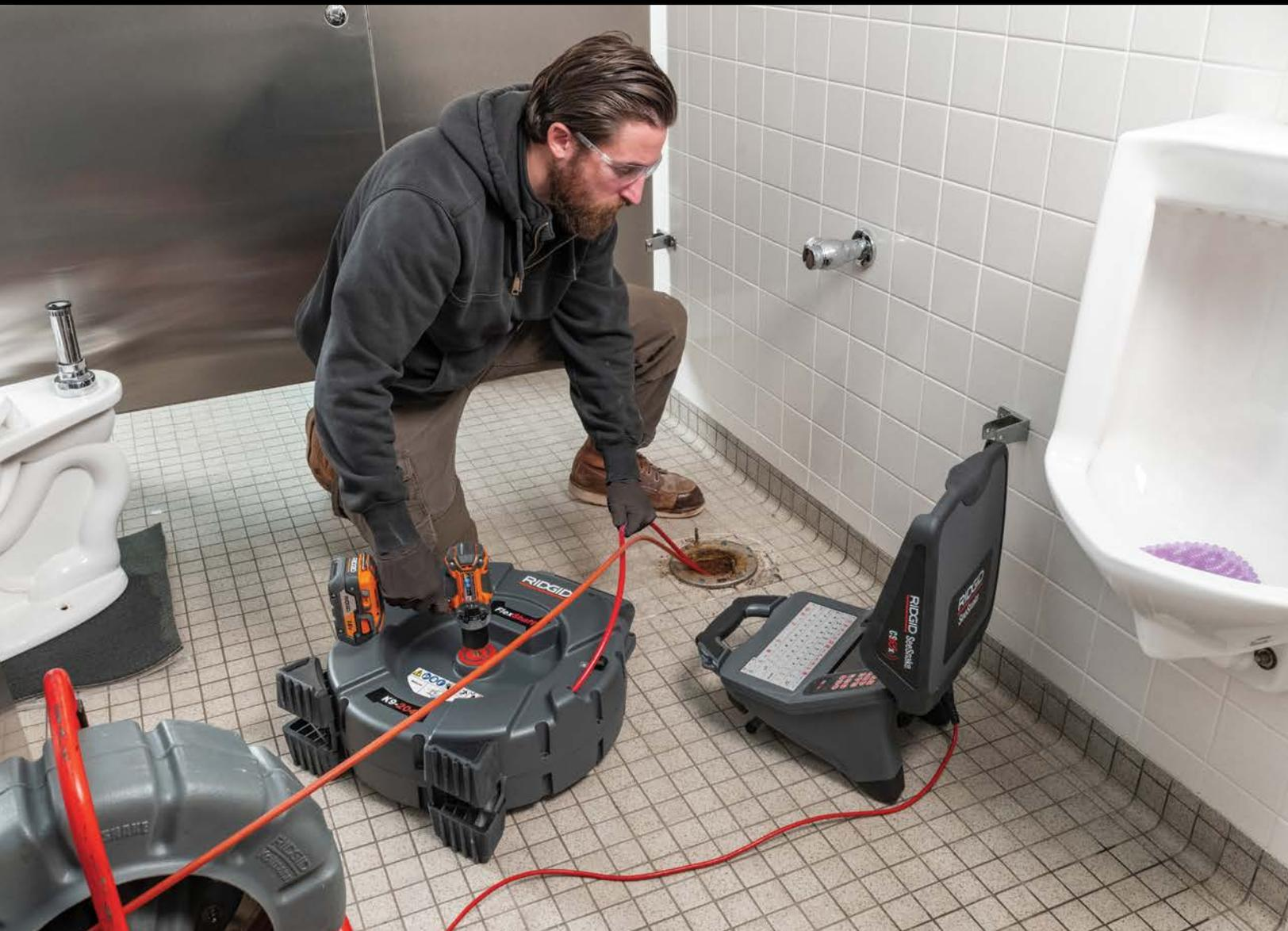
As desentupidoras FlexShaft RIDGID são leves, compactas e altamente eficientes. Fornecem limpeza de parede à parede em linhas de drenagem de 1¼" a 4" até 21m. As desentupidoras FlexShaft também podem ser operadas enquanto uma câmera de inspeção estiver na linha, permitindo a inspeção durante a limpeza. Nenhum outro especialista em obstrução leve pode fazer isso.
